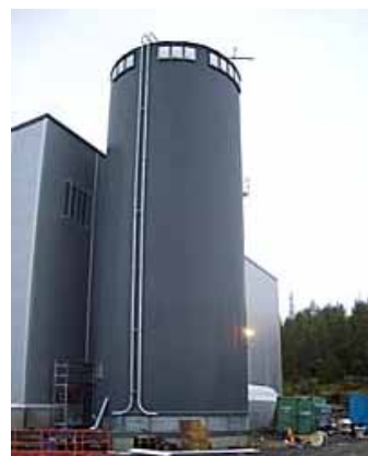
Umeå Energi: Pelletssilo 800 m 3 Saxlunds och TPS.
