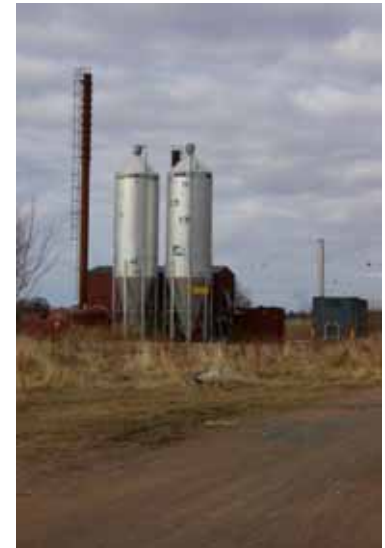
Gränna 14 MW värme MAFA silos, pellets.
